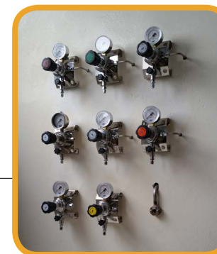
Pontos de gases para o equipamento IRMS de fluxo contínuo modelo Delta V, ThermoFisherScientific.
